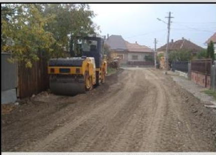
Strada Nucului - pregătire pentru asfaltare
