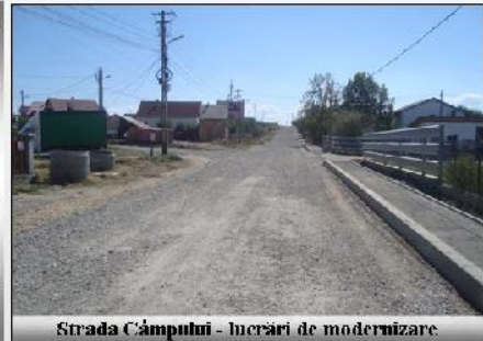
Strada Câmpului - lucrări de modernizare
