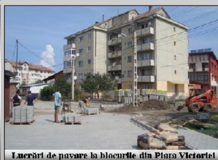
Lucrări de pavare la blocurile din Piața Victoriei
