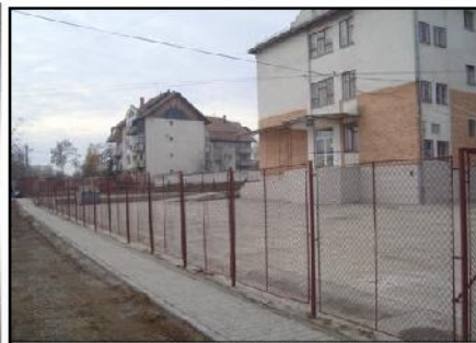
Amenajarea trotuarului de lângă "Școala Nouă"
