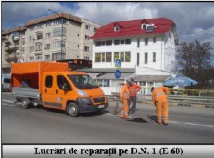
Lucrări de reparații pe D.N. 1 (E 60)
