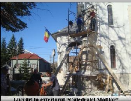
Lucrări la exteriorul "Catedralei Moșilor"
