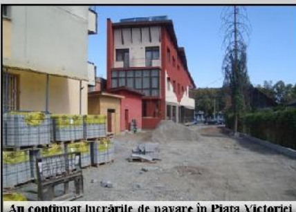
Au continuat lucrările de pavare în Piața Victoriei
