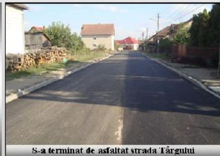
S-a terminat de asfaltat strada Târgului
