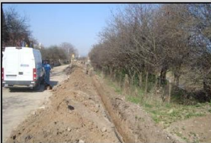
Lucrări pe strada Stadionului și Florilor (parțial)
