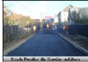
Strada Poniilor din Huedin - asfaltare
