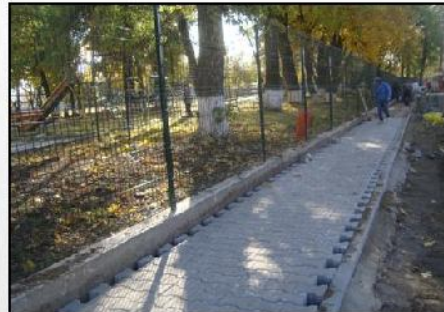
Amenajarea trotuarului de lângă "Parcul Mare"
