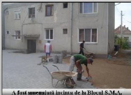
A fost amenajată incinta de la Blocul S.M.A.
