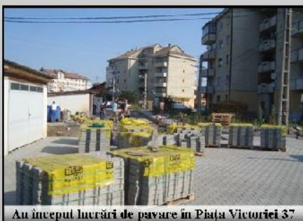
Au început lucrări de pavare în Piața Victoriei 37
