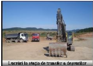
Lucrări la stația de transfer a deșeurilor
