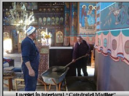
Lucrări în interiorul "Catedralei Moșilor"
