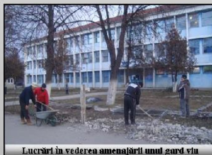
Lucrări în vederea amenajării unui gard viu
