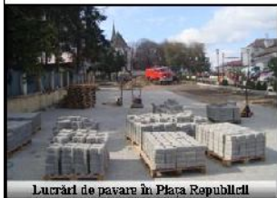
Lucrări de pavare în Piața Republicii
