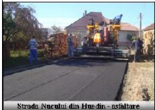
Strada Nucului din Huedin - asfaltare
