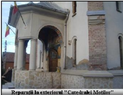
Reparații la exteriorul "Catedralei Motilor"
