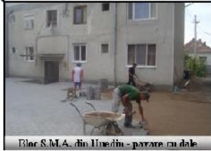
Bloc S.M.A. din Huedin - pavare cu dale
