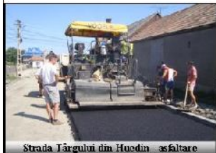
Strada Târgului din Huedin - asfaltare
