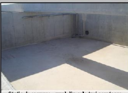
Stația de epurare - unul din cele trei aeratoare
