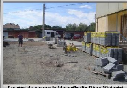
Lucrări de pavare la blocurile din Piața Victoriei
