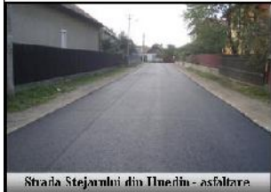
Strada Stejarului din Huedin - asfaltare
