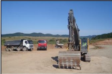
Lucrări la Stația de selectare/transfer a deșeurilor
