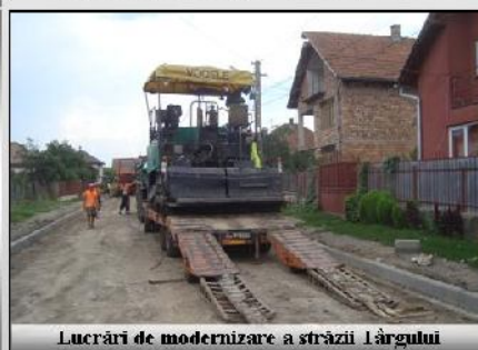
Lucrări de modernizare a străzii Târgului
