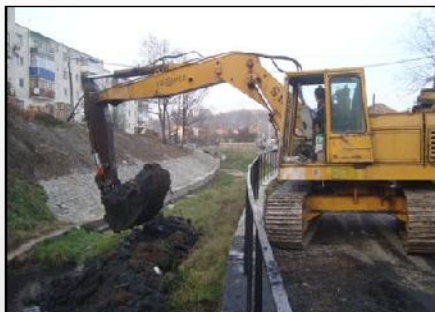
Lucrări de decontaminare a albiei râului Domos
