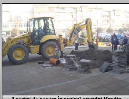
Lucrări de pavare în centrul orașului Huedin
