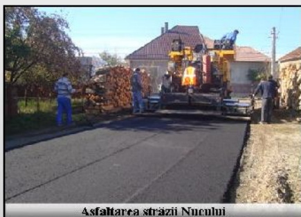
Asfaltarea străzii Nucului
