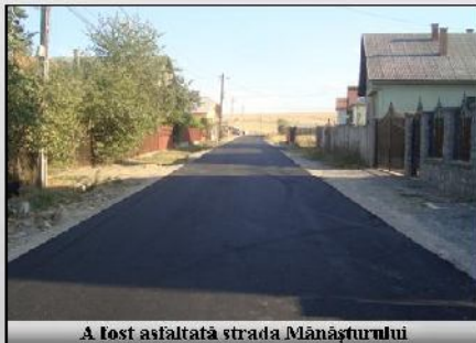
A fost asfaltată strada Mănăsturului
