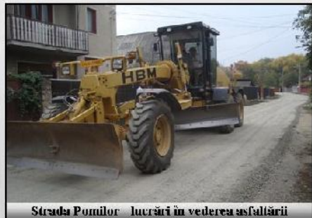
Strada Pomilor - lucrări în vederea asfaltării
