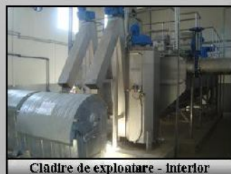
Clădire de exploatare - interior
