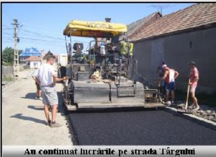
Au continuat lucrările pe strada Târgului
