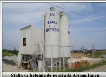
Stația de betoane de pe strada Avram Iancu
