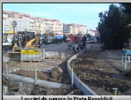
Lucrări de pavare în Piața Republicii
