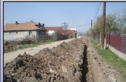
Înducerea conductei de apă pe strada Stadionului
