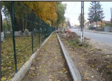
Amenajarea trotuarului de pe strada Avram Iancu
