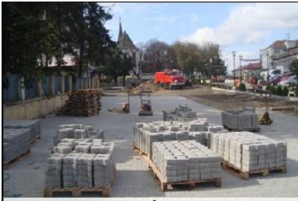
Lucrări de pavare în Piața Republicii
