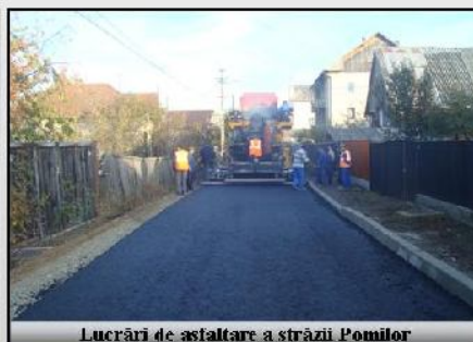
Lucrări de asfaltare a străzii Pomilor
