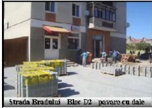
Strada Bradului - Bloc D2 - pavare cu dale
