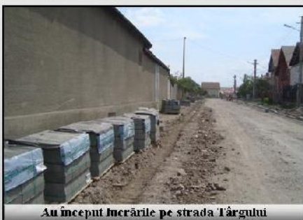
Au început lucrările pe strada Târgului
