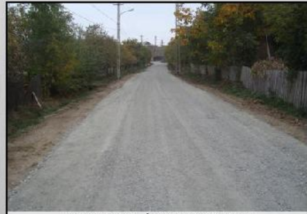
Strada Viilor - înainte de asfaltare
