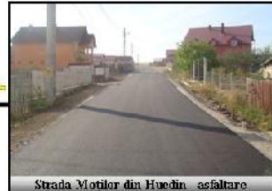
Strada Motilor din Huedin - asfaltare
