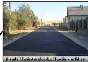
Strada Mănăsturelui din Huedin - asfaltare
