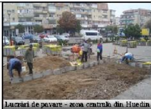
Lucrări de pavare - zona centrală din Huedin
