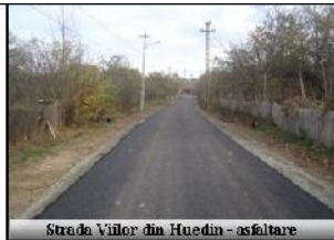
Strada Viilor din Huedin - asfaltare
