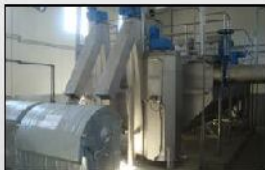
Clădire de exploatare - interior
