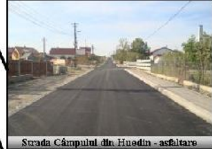
Strada Câmpului din Huedin - asfaltare
